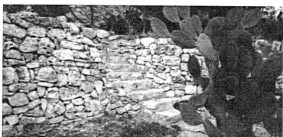
Opere di ingegneria idraulica-agraria: il progetto prevede il recupero e la ricostruzione dei muri a secco della gravina.
